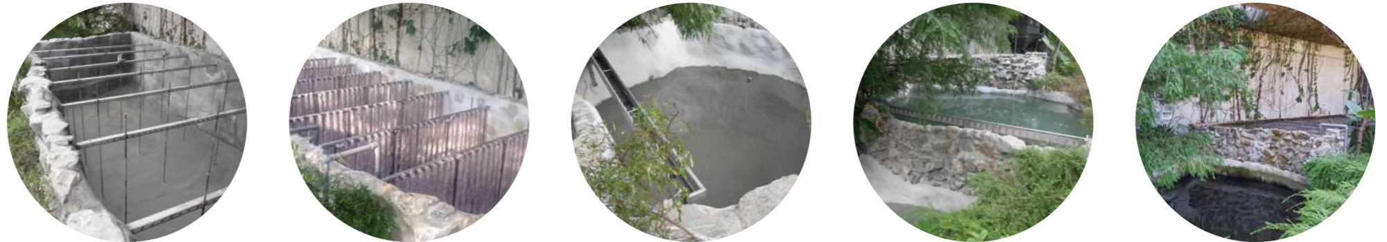
● 圖 2-13 廢水處理設施效能提升改善作業
