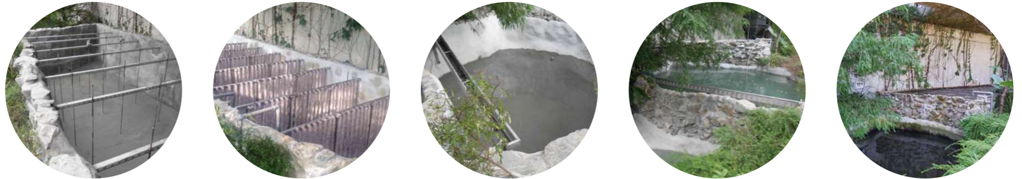
● 圖 2-10 廢水處理設施效能提升改善作業
